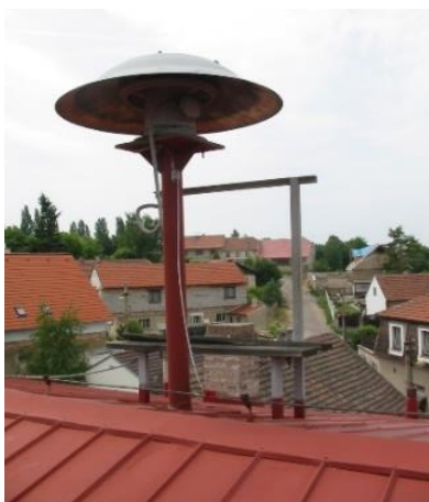
Obr. č. 9 Elektromechanická siréna
