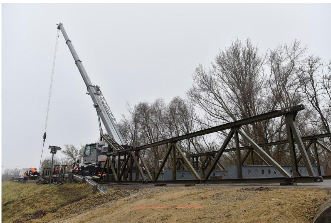
Obr. č. 5 Ukázka výstavby provizorního mostu
